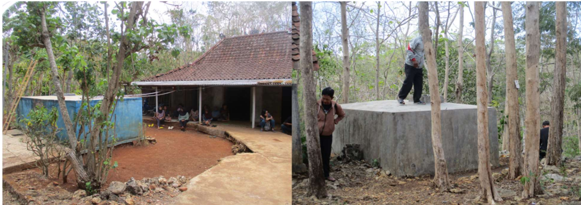
Gambar 2. Survey lokasi bak penampungan air bersih
